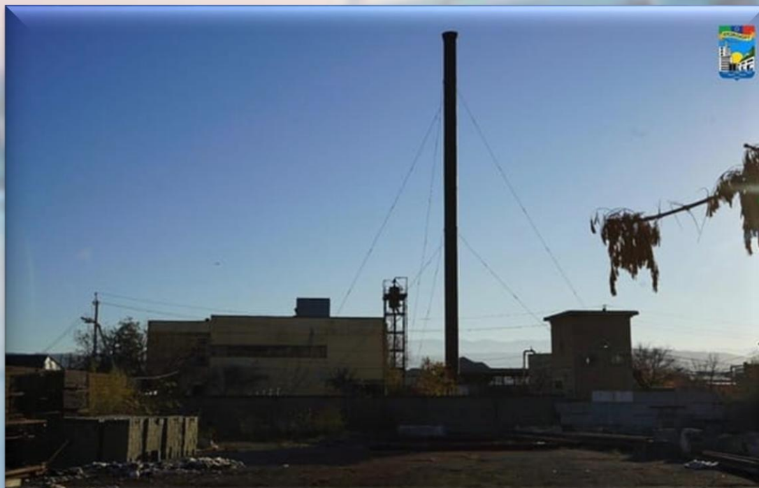
Котельная «Жилмассив», год ввода в эксплуатацию 1972.
